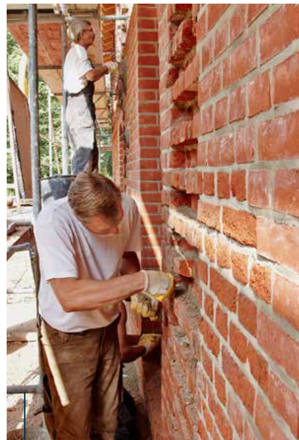
Restauratoren werden im Handwerk benötigt.
