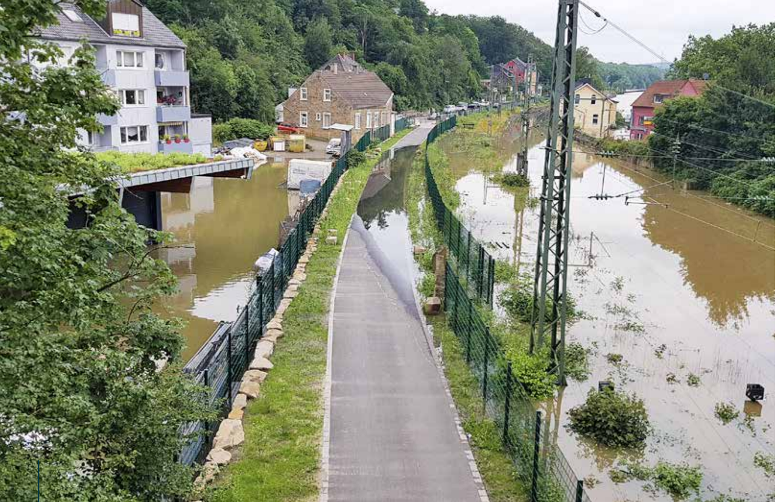
Der Dachdeckerbetrieb von Jörn Hoose war vom Hochwasser betroffen.
