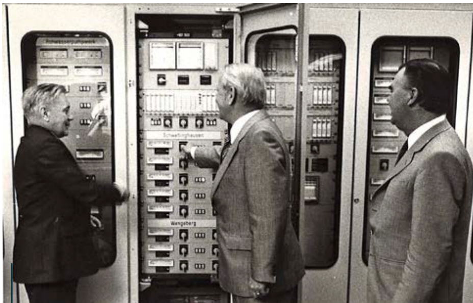
Offizielle Einweihungsfeier des Wasserwerks am 22. Juni 1979: der obligatorische Knopfdruck von Staatssekretär Dr. Arnold Ebert (NRW-Landwirtschaftsministerium) mit AVU-Direktor Karl Marx (l.).
